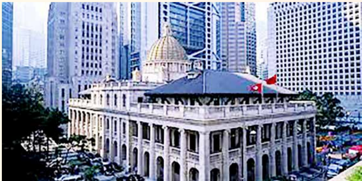
終審法院採用新古典主義派的建築風格，仿效古羅馬及希臘的建築設計，地面以愛奧尼亞式石柱環抱。（資料來源：discoverhongkong）
